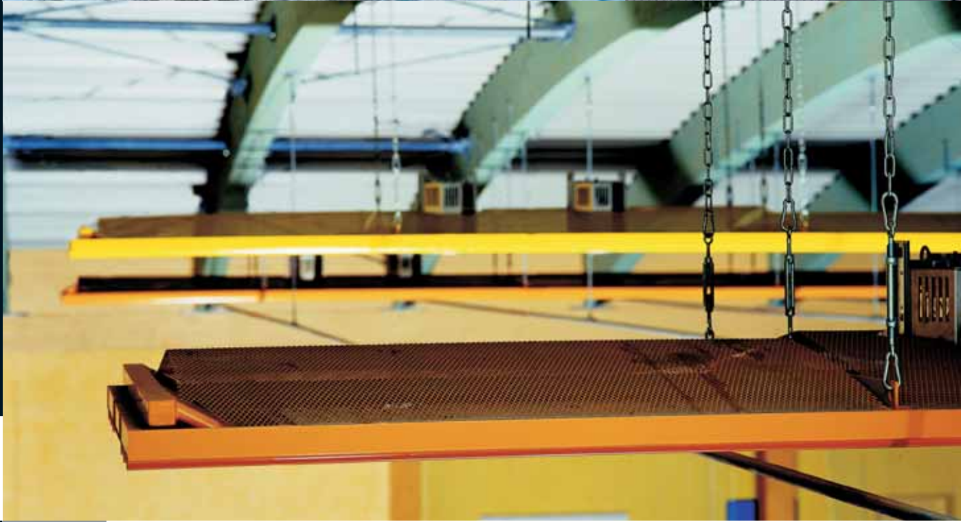
Спортзал в Оффенбурге. Потолочные панели Zehnder с защитной решёткой от попадания мяча, встроенными светильниками и приподнятыми коллекторами.
