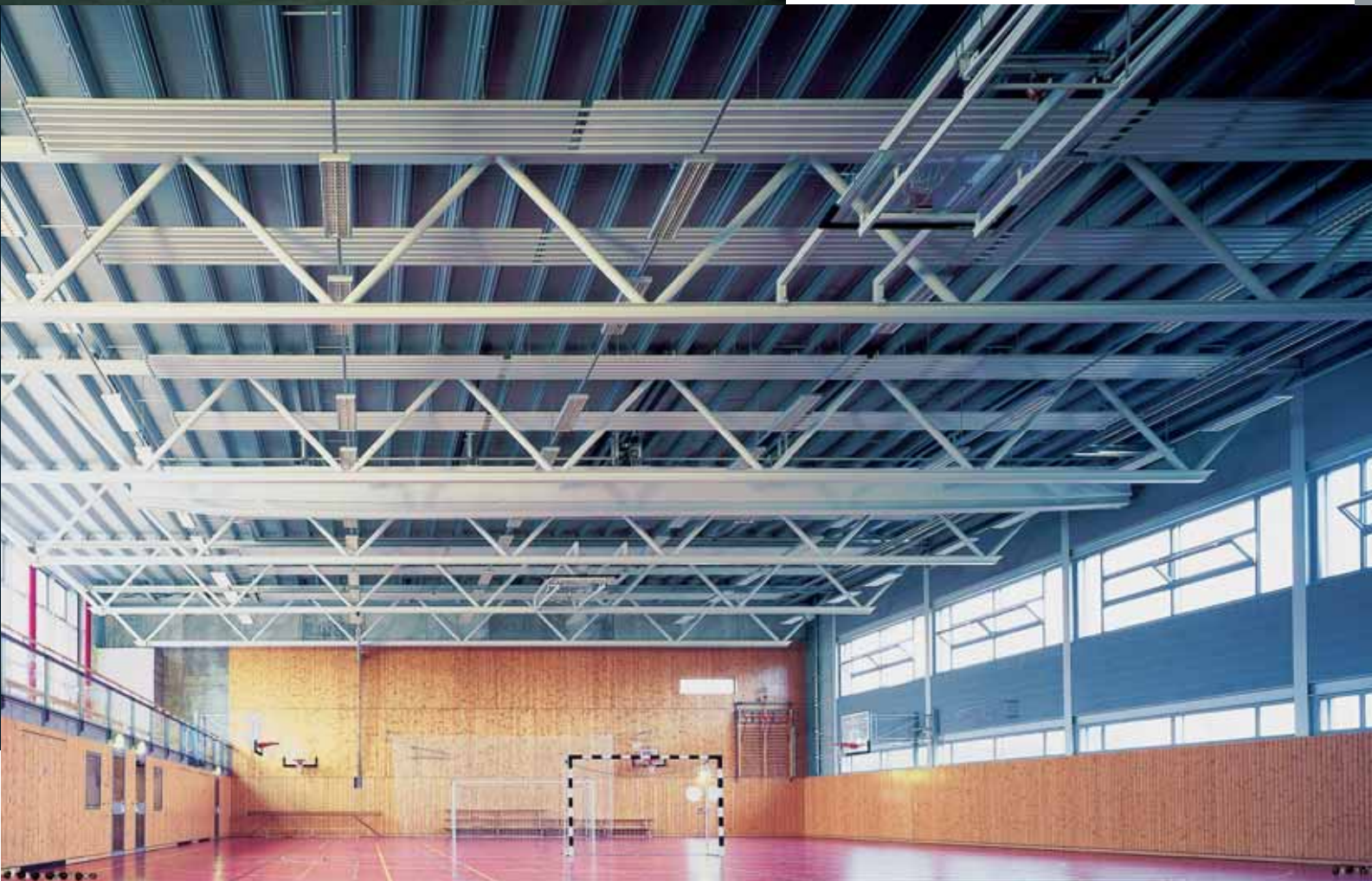
Спортзал в Хенигсдорфе. Потолочные панели Zehnder с защитной сеткой от попадания мяча.
