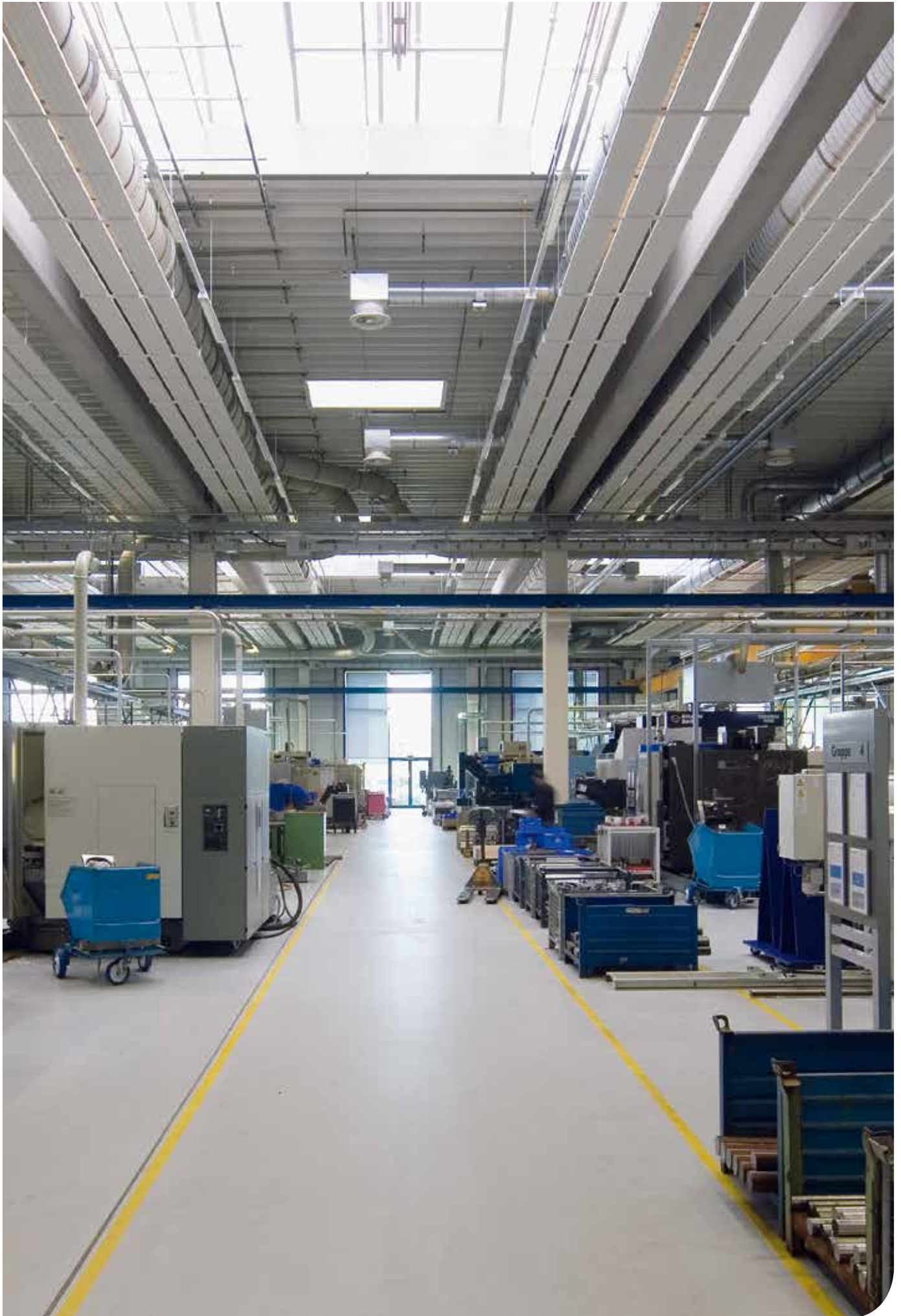
Производственные помещения компании Ohnhäuser, Валлерштайн (Германия)
